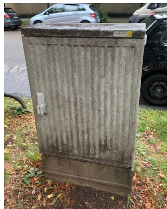
Gehäuse aus Polycarbonat oder glasfaserverstärktem Kunststoff altern im Lauf der Jahre und können nicht mehr oder nur mit großem Aufwand gereinigt werden. Darüberhinaus treten bei glasfaserverstärktem Kunststoff spitze Glasfaserenden aus der Oberfläche aus und können zu Verletzungen führen.
