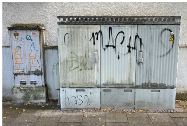
Gehäuse aus Polycarbonat oder glasfaserverstärktem Kunststoff altern im Lauf der Jahre und können nicht mehr oder nur mit großem Aufwand gereinigt werden. Darüberhinaus treten bei glasfaserverstärktem Kunststoff spitze Glasfaserenden aus der Oberfläche aus und können zu Verletzungen führen.
